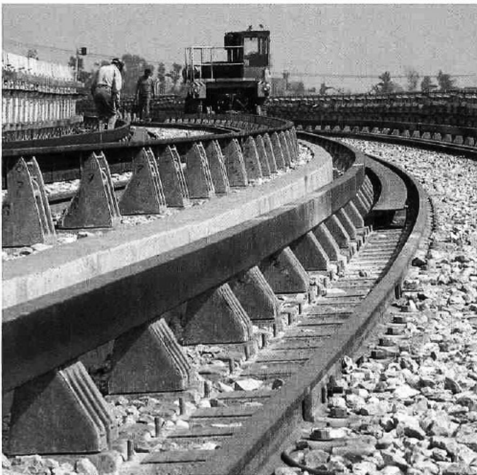
Perfiles de la vía del Metro de la Ciudad de México.
