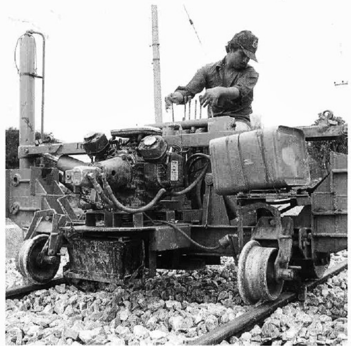
Nivelación de riel; abajo: transformador de potencia en una subestación; página opuesta: interruptor bipolar en la subestación.
